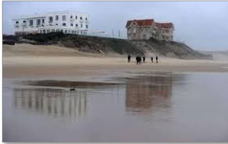
Erosion du littoral à Biscarrosse (40), Grand Hôtel de la plage et les Villas Jumelles évacués par un arrêté de péril.
